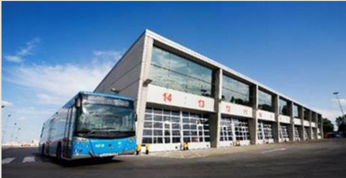
Entorno semi-controlado: Centro de operaciones de EMT de Carabanchel
